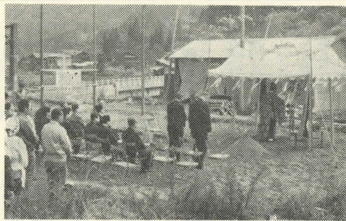
越美北線延長工事起工式
