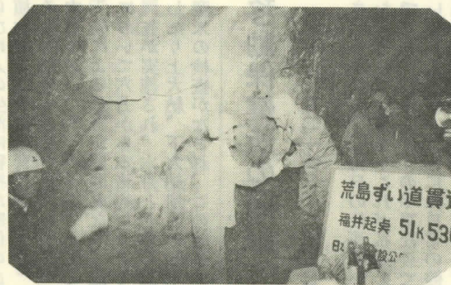
貫通した荒島トンネル
