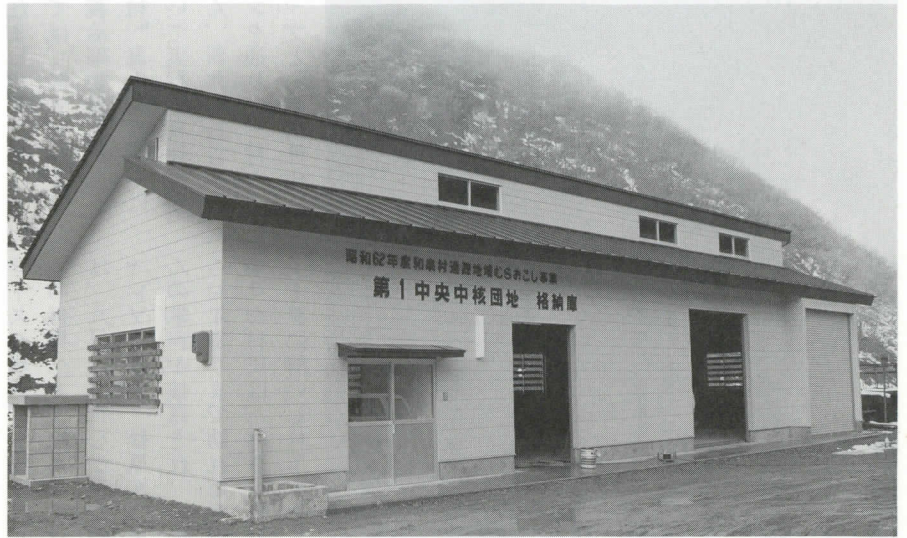
▲第一中央中核団地 格納庫兼事務所 (板倉)
